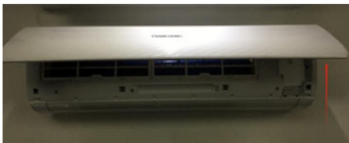
1.2 Dévisser les vis de boîte WiFi. Différents types de climatisation, l'emplacement des boîtes WiFi peut être différent.
